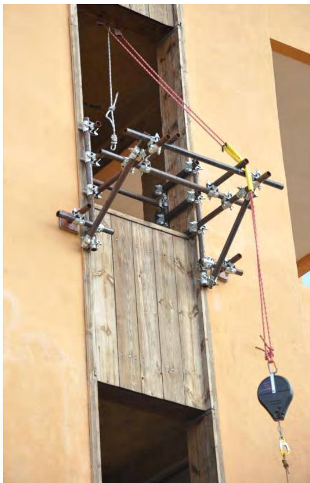
Figura 10: Foto dell'ancoraggio e del distanziatore che posiziona il dispositivo retrattile per l'esecuzione della manovra della scala italiana.
