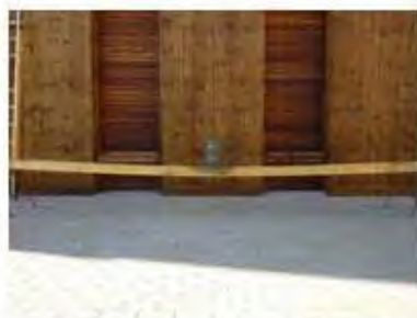
Seconda misurazione (peso applicato)
