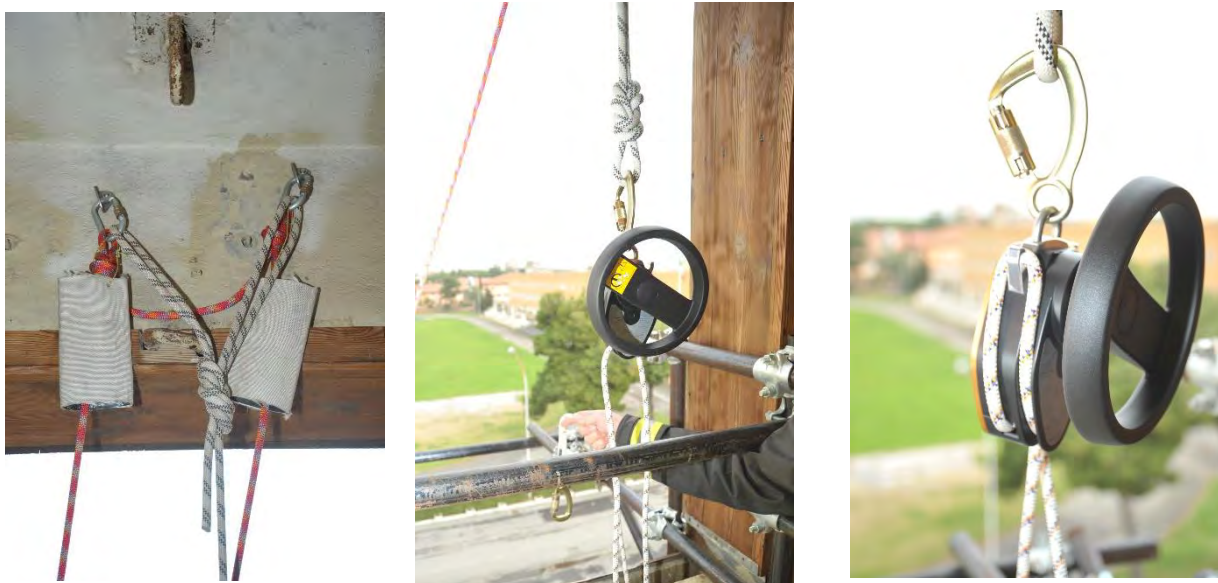
Figura 25: Ancoraggio e posizionamento dell'evacuatore
