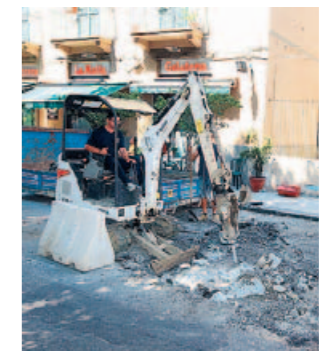
I lavori in via La Farina
